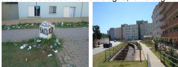
Fig. 4 Ausência de varrição pública e coleta de lixo (à esquerda) e ausência de iluminação pública (à direita). Fonte: Maria de Lourdes Zuquim, 2009
