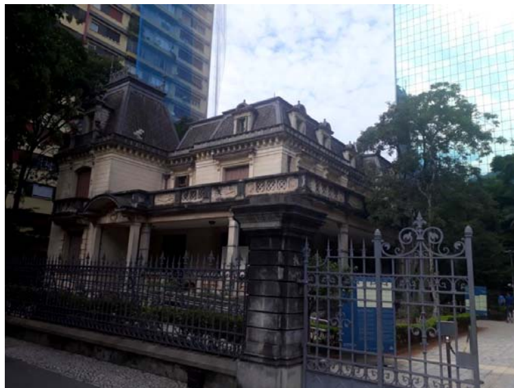
Figura 2 – Casa das Rosas e Edifício Parque Cultural Paulista (torre de vidro) Fonte: Foto do autor.
