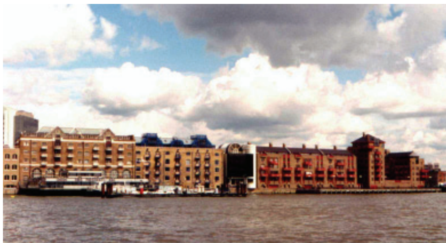
Figura 1: Renovação urbana das docas de Santa Catarina em Londres Foto: Autor, 1994
